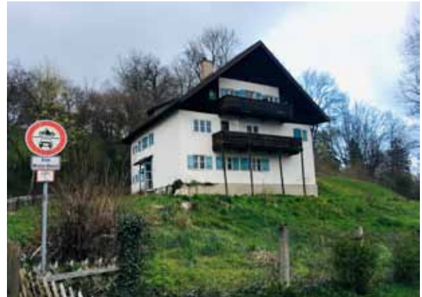
leerstehendes, sanierungsbedürftiges Gebäude am Valloch
