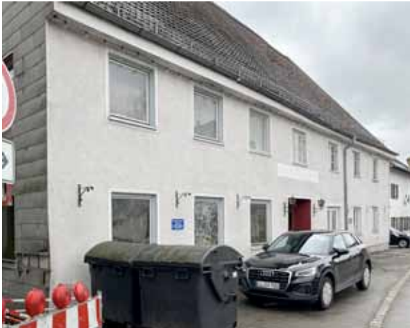
Gebäude mit Nutzungsaufgabe
