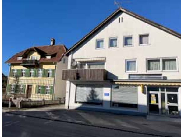
Erhalt historischer Gebäude und Hofstrukturen
